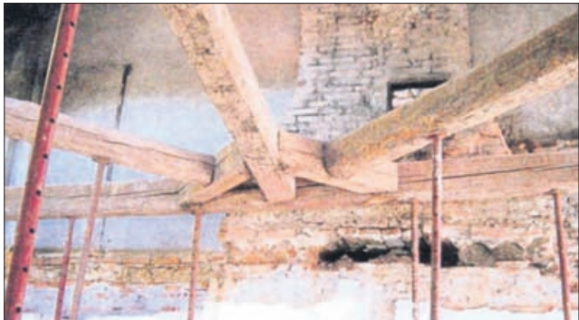
Temeljiti posegi v ostrežje stare stavbe so bili šele leta 2006; pred začetkom del je bilo treba dotrajano strešno konstrukcijo podpreti.
