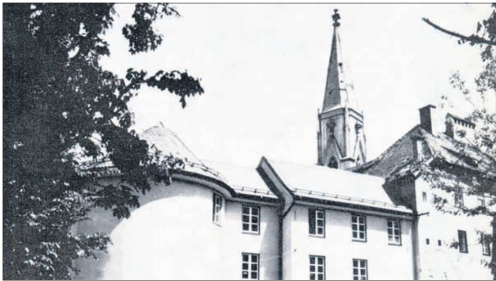
Novi del poslopja Glasbene šole Celje; na desni se ga drži stara stavba, ki je bila obnovljena precej kasneje.
