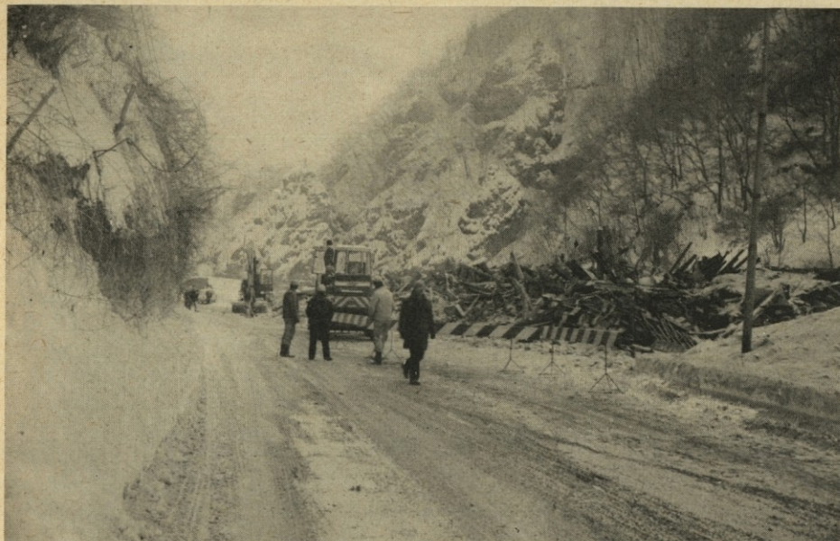
Dne 12. februarja so delavci Geološkega zavoda iz Ljubljane minirali in odstrelili tudi tretjo stanovanjsko hišo pri Sušniku. (foto: A. Bregant)
