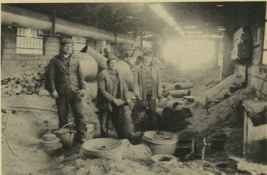
Kurilne in zračilne kanale ter tla vrh krožne peči na Opekarni izvaja delovna skupina tozd GRAMAT. (foto: A. Bregant)
