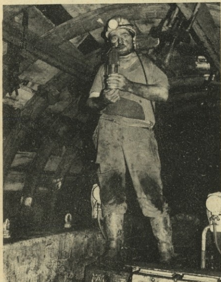
Kontrola metana z bencinsko varnostno svetilko na delovišču AB polju kote 284 v jami rudnika Trbovlje (foto: B. Klančar)
