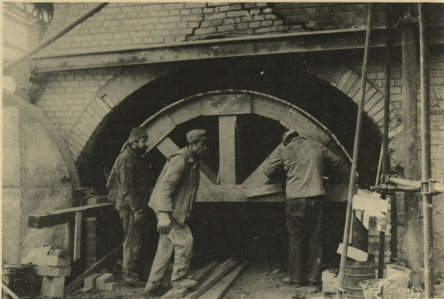
Tozd GRAMAT izvaja na Opekarni popravilo krožne peči za žganje opeke. Na portalu izvaja vzdrževalna dela skupina iz trboveljske Cementarne. (foto: A. Bregant)
