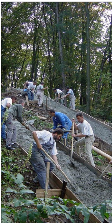
Naporno jesensko betoniranje naletov za obe novi skakalnici
