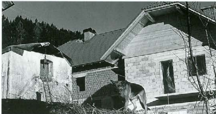
Po požaru uničeni Lauterjevi poslopji sta že pod streho.
