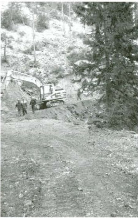
Gradnja gozdne ceste Jeverčnik– Vranske peč (vir: arhiv ZGS)
