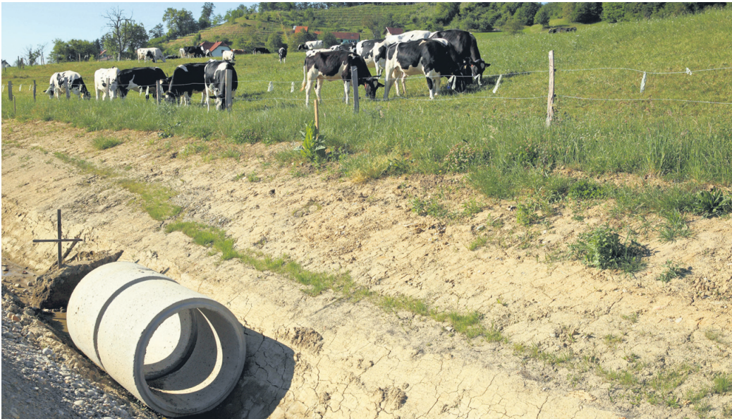
V 17 podravskih občinah je zgolj tretjina gospodinjstev priključenih na javno kanalizacijsko omrežje.
