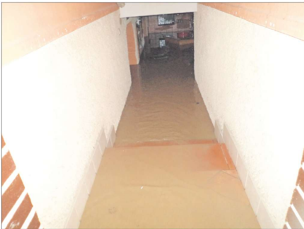
Takole se je voda zlivala po stopnicah v lokal. (Foto: Matic Filipič)
