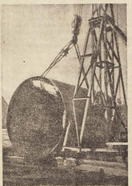
Pred spuščanjem vrtalnega ščita »krt« v jarek, kjer začnejo kopati kanal
