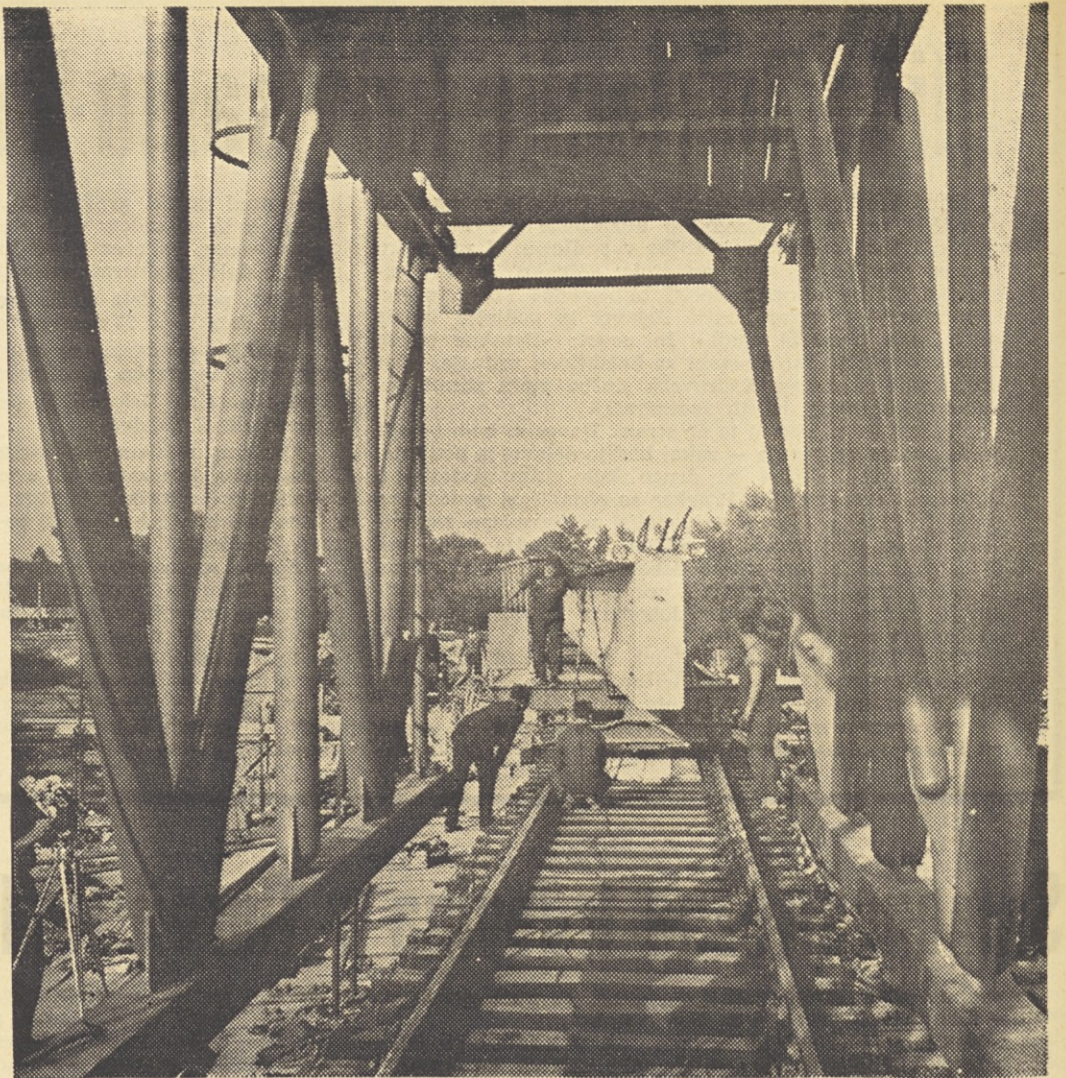
Konstrukcija veržejskega mostu
