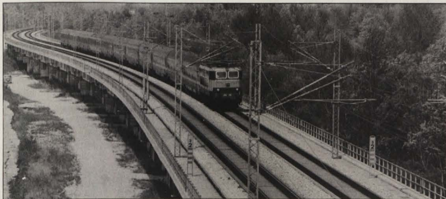
Viadukt „Rivoli bianchi“ blizu mesta Venzone je s 1050 metri najdaljši most, zgrajen pa je po novem načinu gradnje, ki dopušča hitrosti nad 200 kilometrov na uro.
