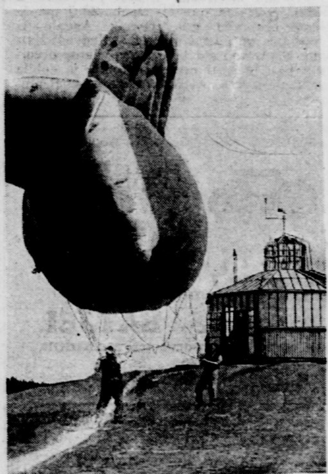
Spušcanje balona z registriranimi aparati na neki meteorološki postaji
