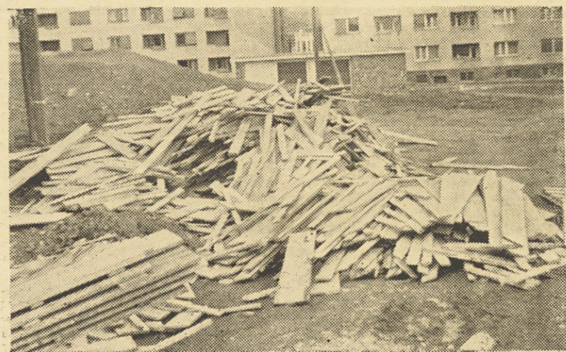
Takšen kup desk leži na gradbišču mariborske tržnice. Skladiščnik je dobil deske brez dobavnice
