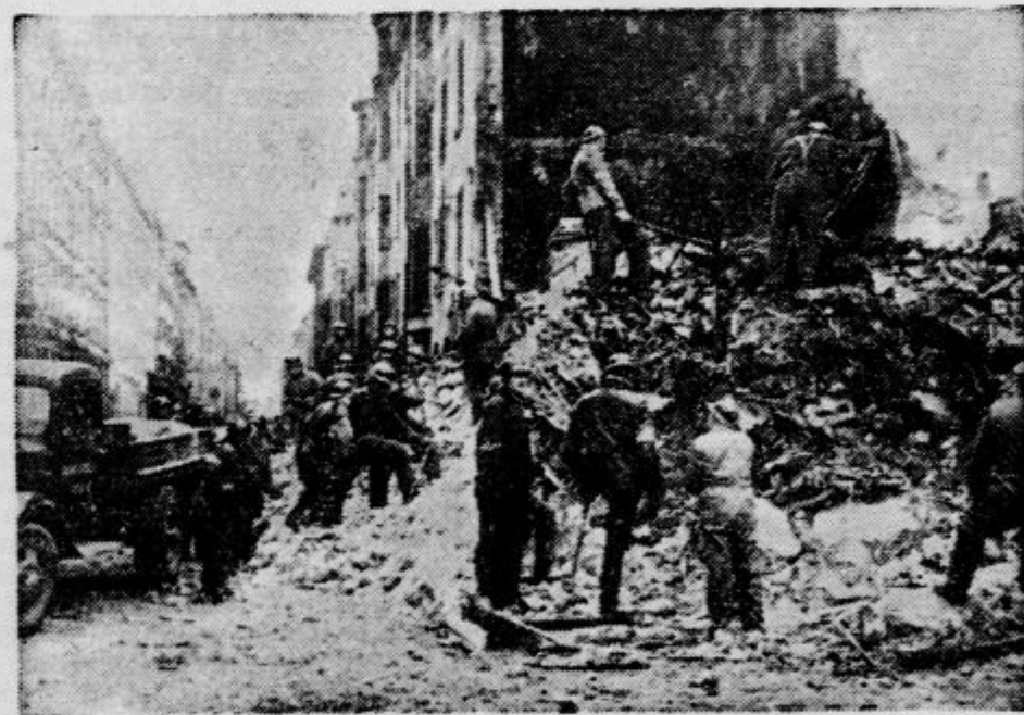
Delavci razkopavajo od bomb porušene hiše v Helsinkih
