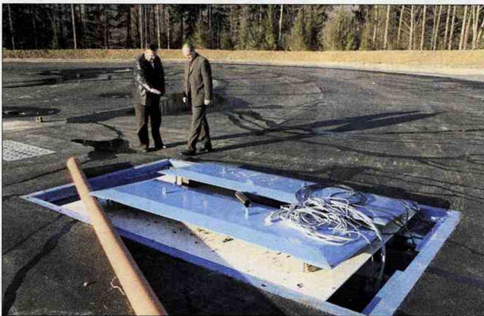
Drсна plošča, vgrajena v cestišče, kjer bo mogoče spoznavati različne kritične situacije in manevre pri vožnji, predvsem zavijanje in zaviranje na mokri in suhi podlagi.
