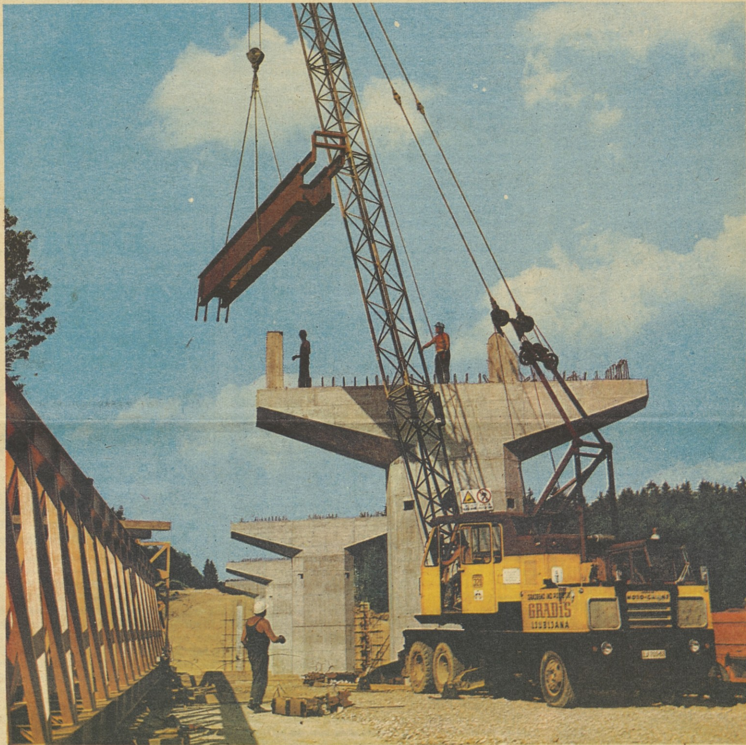
Avto cesta Hoče-Levec hitro dobiva svojo podobo. K temu sta pripomogli predvsem sodobna mehanizacija in moderna tehnologija dela. - Foto: A. AGNIČ
