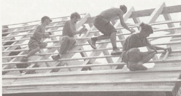
Obnova strehe v Kotor Varošu. Foto: Arhiv B. Vidmar
