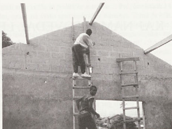
"Mojstri" pri popravljanju strehe cerkve. Foto: Arhiv B. Pregelj
