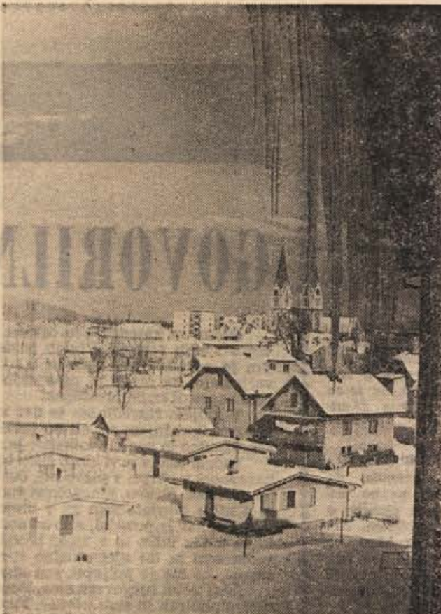
Čudovit pogled za fotografa, a smrtna nevarnost za stanovalce. Ledene sveče, ki so te dni po odjugi visele s streh, so precej poškodovale žlebove, za kar bo moralo stanovanjsko podjetje spomladi najbrž odšteti lepe denarje. (Foto: France Brus)
