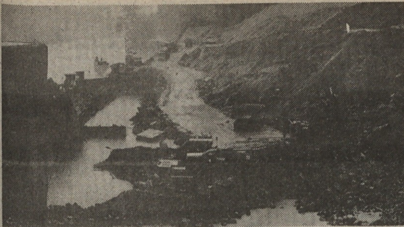
Gradbena jama nove strojnice HE Fala na desnem bregu Drave. Na levi strani fotografije se začneja stari jez.
