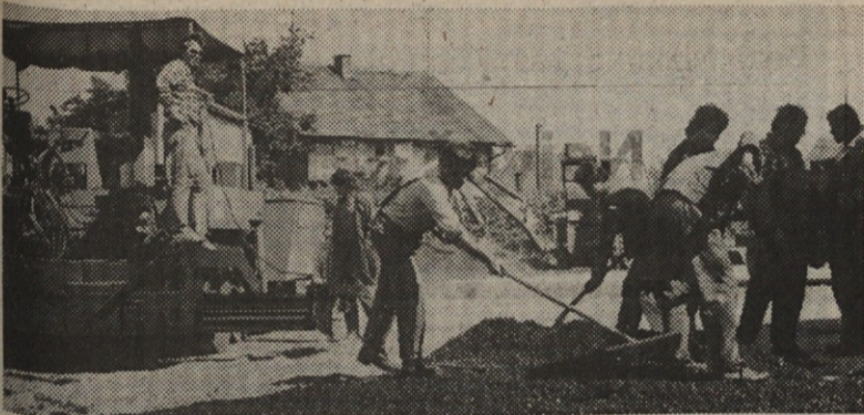
Delavci Nizkih gradenj polagajo asfalt pri Gumarni v Mariboru
