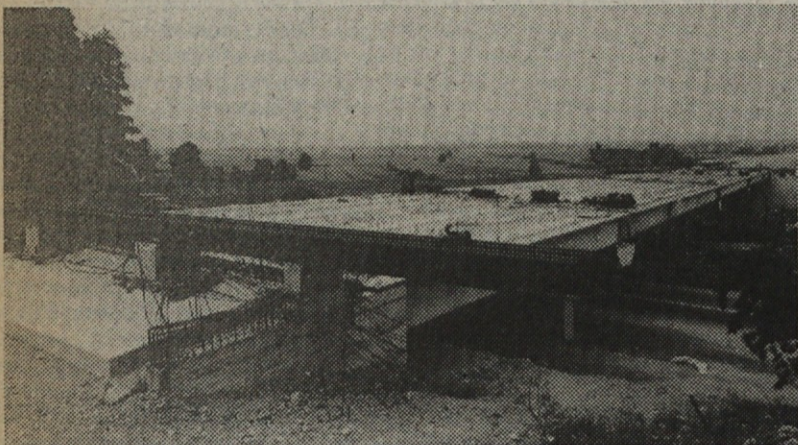
Na viaduktu južne obvoznice preko Dolenjske ceste in železnice se montirajo nosilci tretjega polja desnega voznega pasu, medtem ko je levi že v celoti zmontiran.
