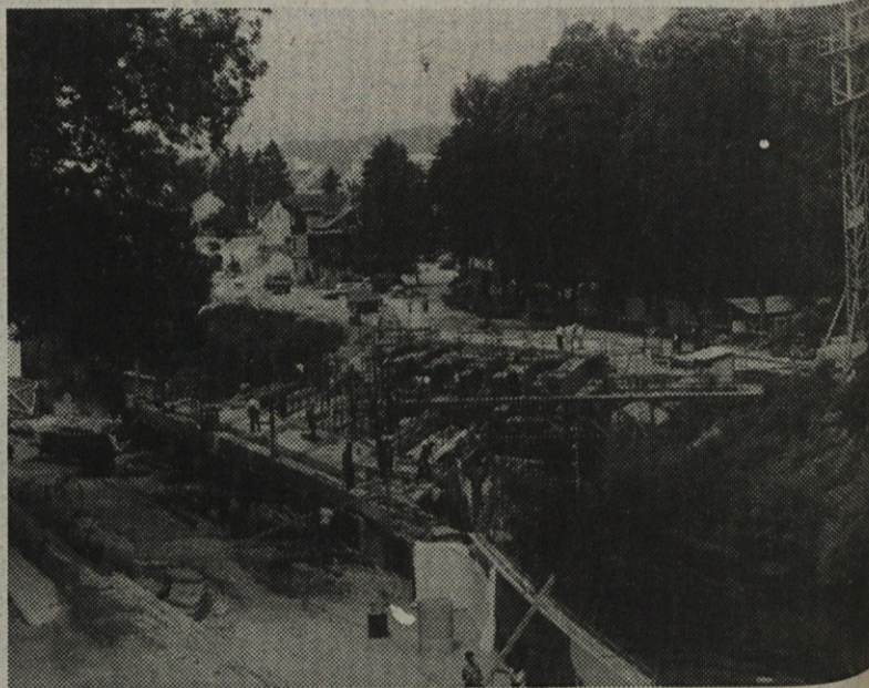
Čeprav majhen, je most čez Grubarjev kanal zaradi segmentne gradnje in montaže šestih ločnih nosilcev izredno zahteven objekt.
