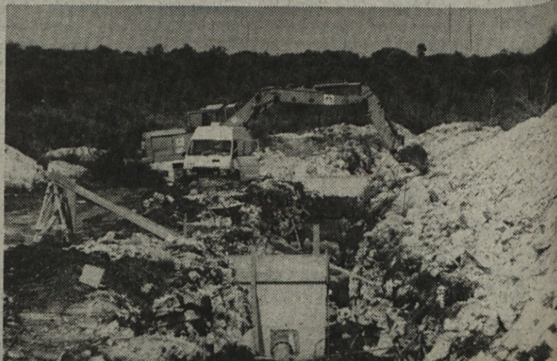
V kamnitem terenu so bili izkopi za cevovode naporno delo. Brez miniranja ni šlo, vihteti pa je bilo treba tudi krampe in lopate
