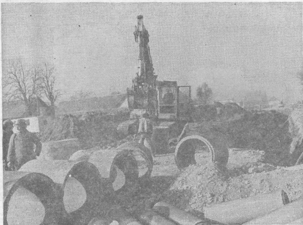
Graditev II. faze Celovške ceste poteka brez zastojev in bo nared do roka
