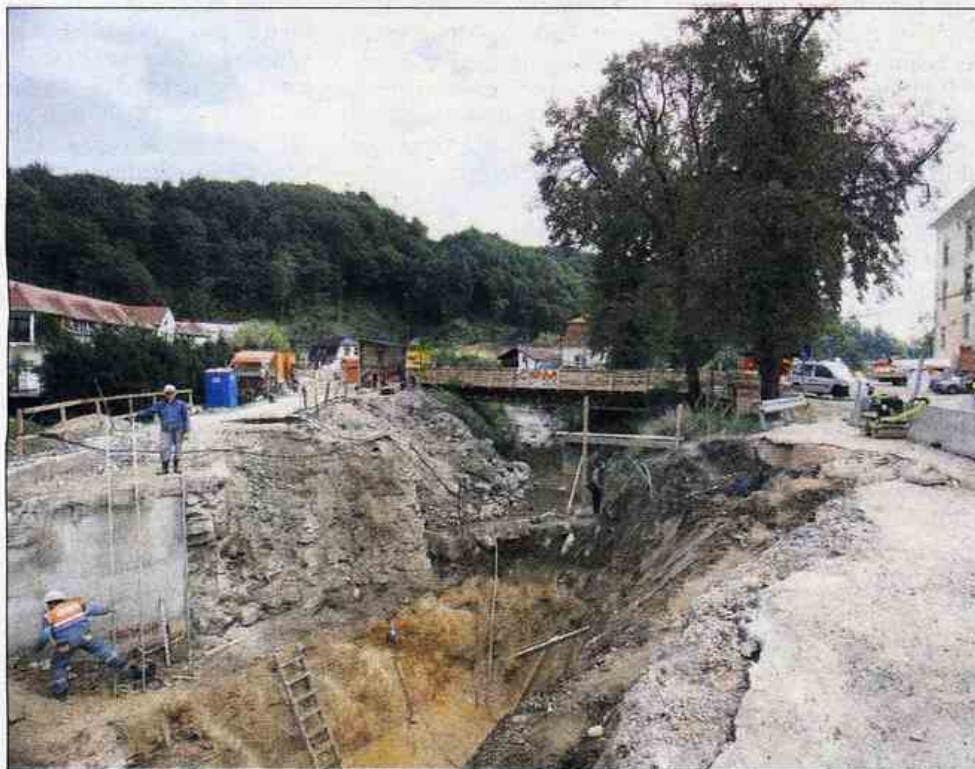
Gradnja mostu v Višnji vasi (Foto: GrupA)
