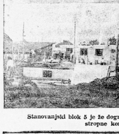
Stanovanjski blok 5 je že dograjen v opečnem zidu do prve stropne konstrukcije
