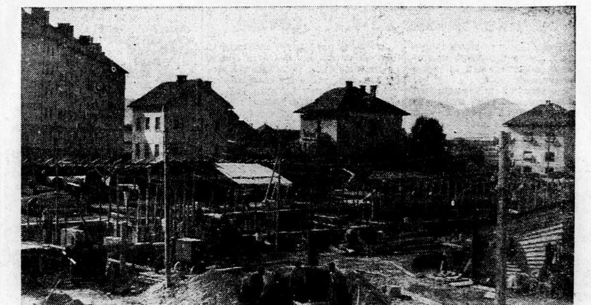
Pogled s Celovške ceste na IV. sektor gradilišča velike stanovanjske kolonije v Šiški, ki jo gradi MEO Ljubljana
