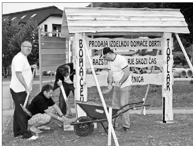
Leseno ogrodje in tablo, ki so ju izdelali lesarski strokovnjaki, so prostovoljci v soboto kljub slabemu vremenu postavili in zabetonirali.
