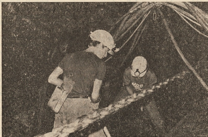
Učenca rudarske šole iz TOZD Rudarski šolski center se uvajata v delo na širokočelnem odkopu v jami Trbovlje, ki je opremljen s samohodnim hidravličnim podporjem Hydromarrel.
