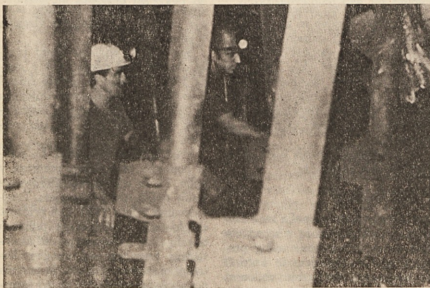
Odkopno čelo v Vode polju v jami premogovnika Trbovlje, opremljeno s klasičnim jeklenim podporjem. Rudarja pri rušenju in izvlečenju, stojk.
