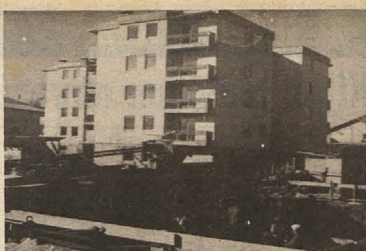
Gradnja novega 27-stanovanjskega bloka v Ribnici se je zaradi obrtniških del zavlekla za okoli mesec dni. V novem bloku so 4 tri-sobna stanovanja, 13 dvosobnih, 9 enosobnih in ena garsonjera. Pri njem so začeli graditi še dva nova bloka s 34 stanovanji. (Foto: Prime)
