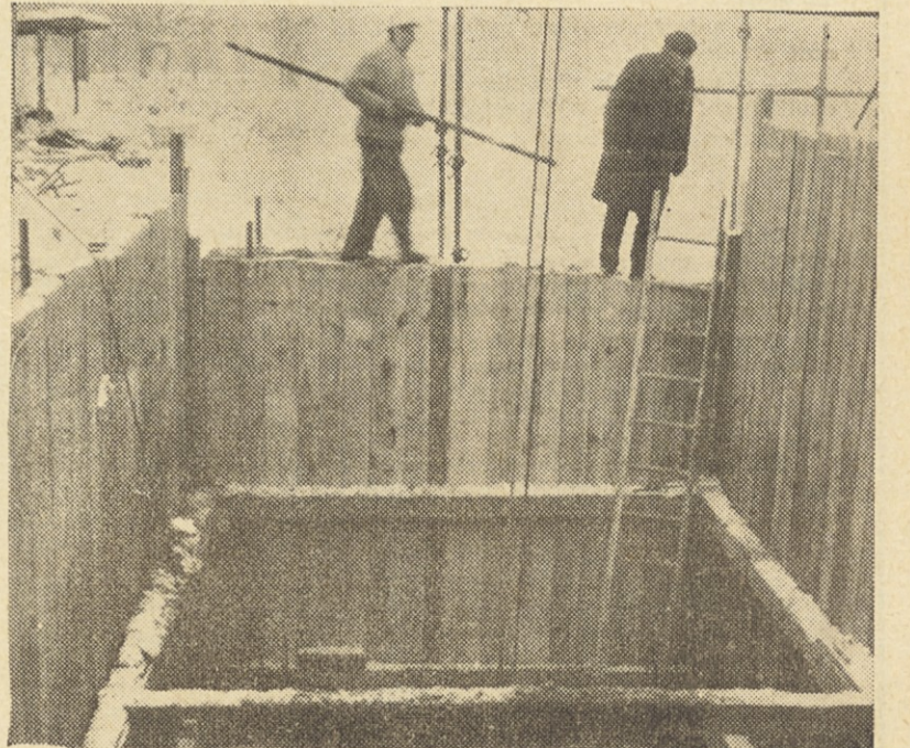
Izkop nosilnega stebra na avstrijski strani. Kopljejo v vodi 5 m v globino
