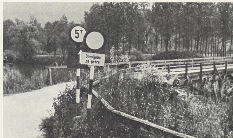
Rešitev Kašelskega mostu bo vendarle boljša. Sedaj zabijajo nove nosilne pilote in popravljajo preostali del mostu. Pričakujemo, da bo pred zimo le varen prehod za naše delavce v tovarno.
