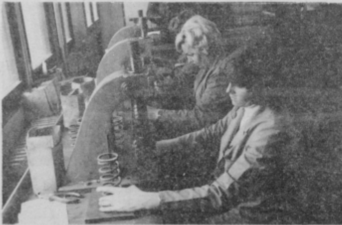
V obratu izdelujejo razne vzmeti, različnih velikosti in oblik.
