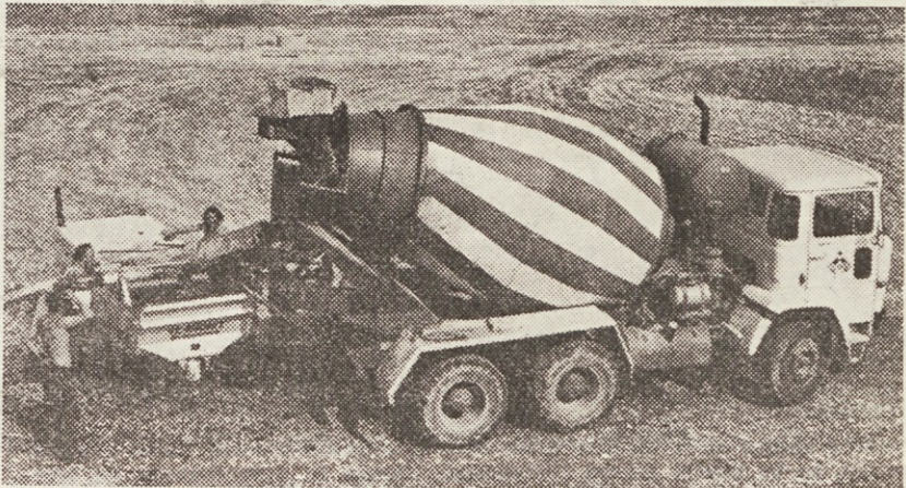
Tudi na gradbišču v Krškem veliko delo opravijo betonske črpalke
