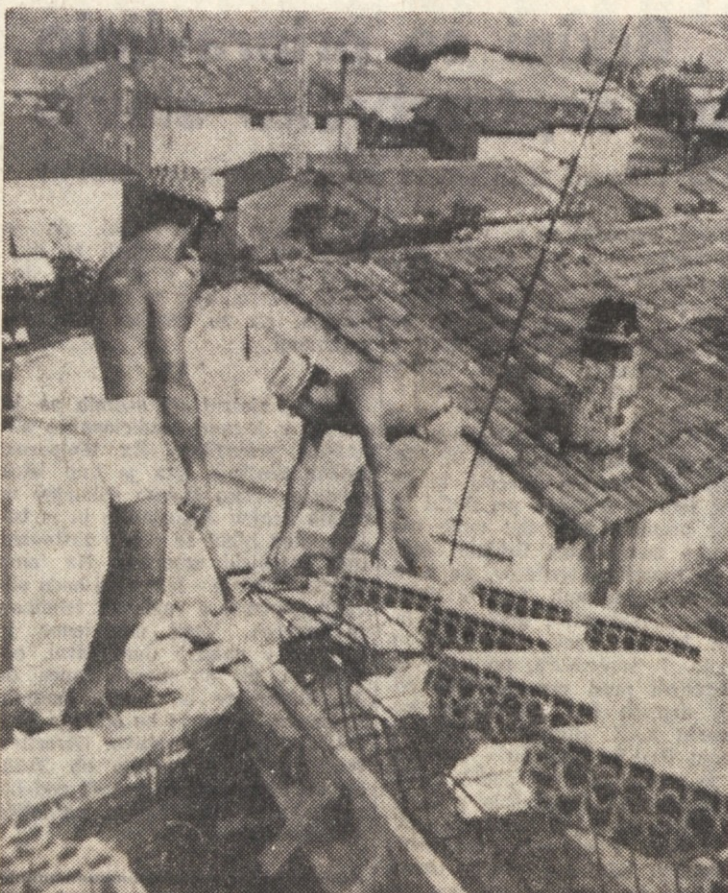
Ena številnih hiš, ki bo kmalu pokrita. Na njej bo čez nekaj dni zaplapolala delavska rdeča zastava. Z »likofom« pa na lastnik pogostil vse delavce, ki so hišo pomagali zgraditi
