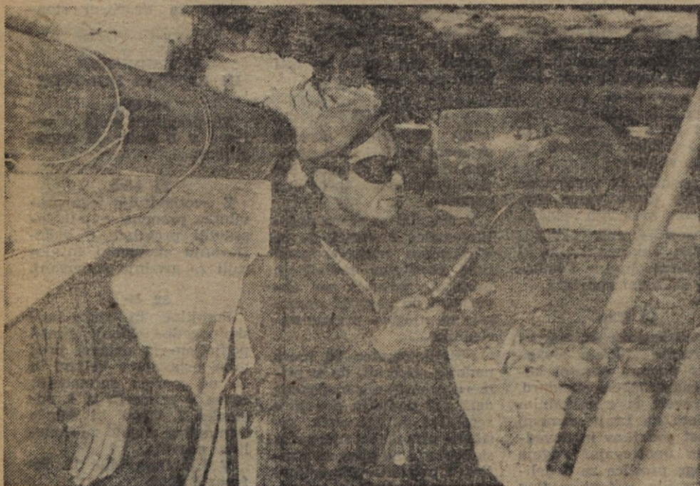
Delovni pogoji naših monterjev so pogosto izredno težki: varjenje magistralnega cevovoda na premičnem montažnem odru pod stropom v kleti pivovarne
