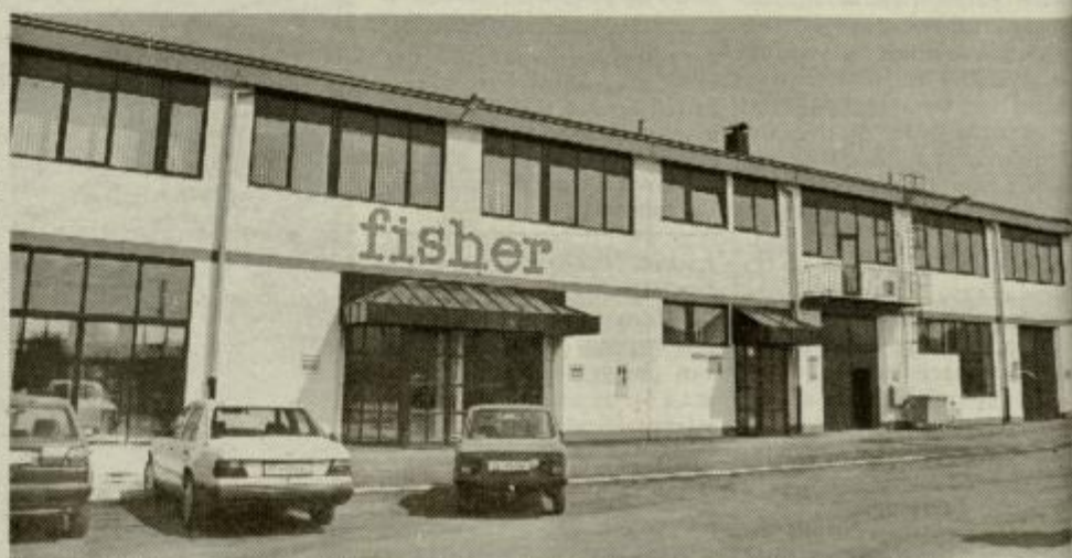
Podjetje Fisher je pred kratkim preselilo svojo dejavnost v novo poslovno stavbo v Bukovžlak.
