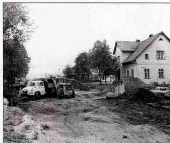
Izkop za gradnjo nove ceste leta 1973. V stavbi na desni strani sta danes trgovini Guerilla Bikes in Katom. Včasih je bila to Lovričkova gostilna.
