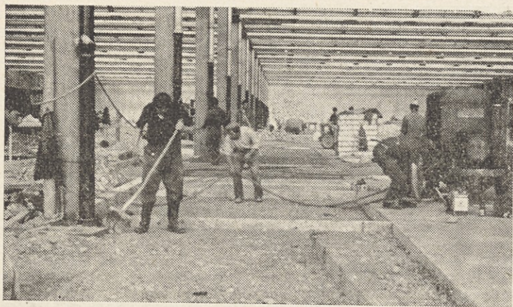
▲ Dela v novi hali za tehnične izdelke gredo sedaj kar hitro naprej, in tudi prve stroje smo že pričeli montirati
