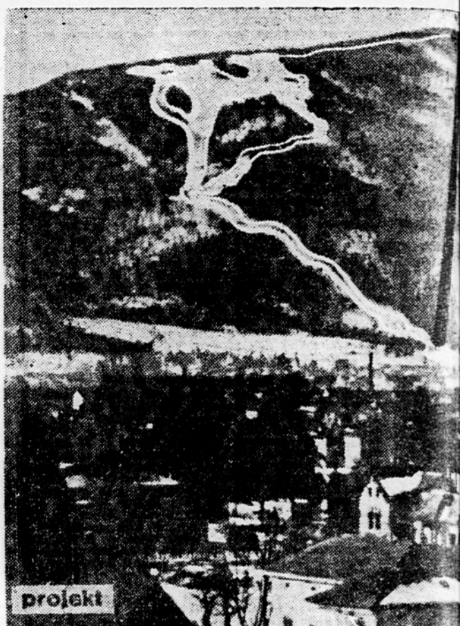
Bela lisa na levi strani slike kaže že obstoječo športno nameno na Pohorju. Temna, ravna črta na desni pa projekt trase bodoče Pohorske vzpenjače.
