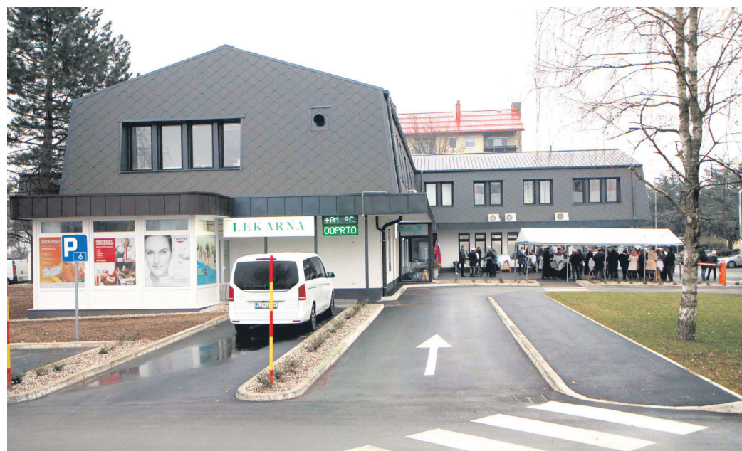
Ob prenovljeni podobi zdravstvene postaje je na novo zaživela tudi njena okolica. Na fotografiji je dovoz do drive in izdajnega okenca za zdravila.
