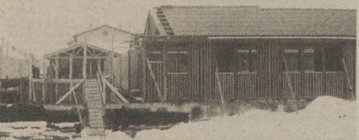
Vrtec za vrhovške malčke bo kmalu zgrajen
