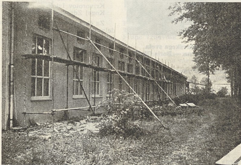
Montiranje klimatskih naprav v TOZD Elektromaterial Lendava
