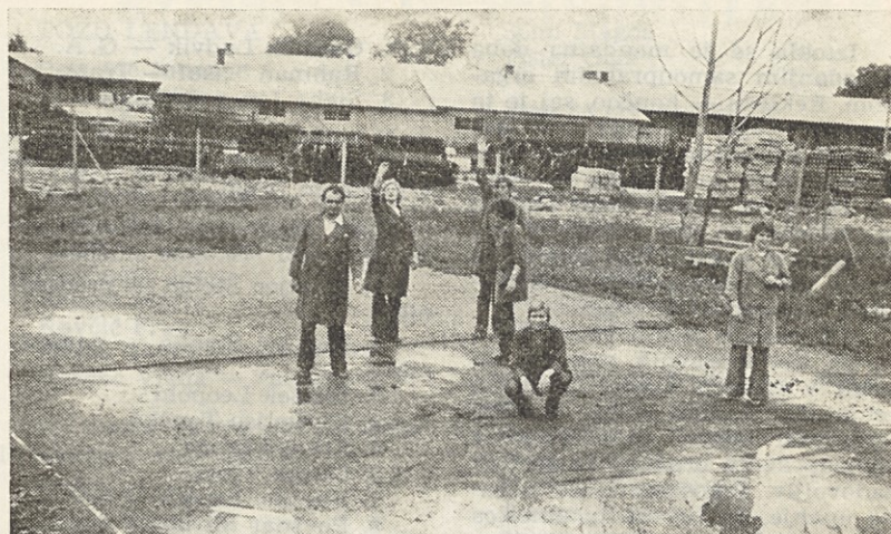
Igrišče za odbojko v TOZD Elektromaterial Lendava pred obnovitvijo
