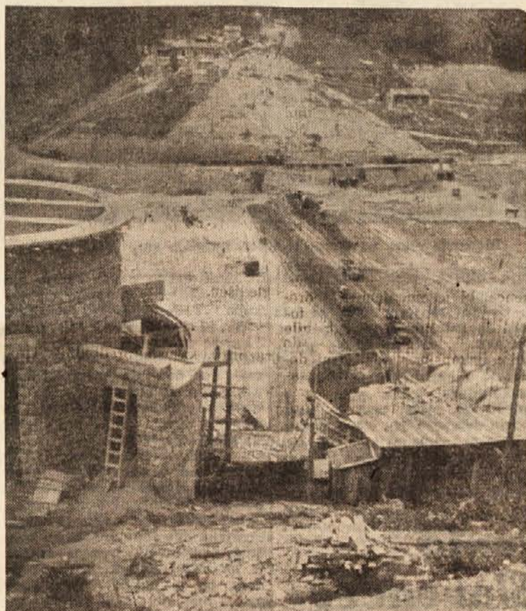
Gradbišče velike hidrocentrale »Nikola Tesla« - Vinodol
