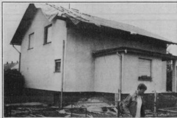
Med številnimi stanovanjskimi hišami je v Gorišnici najhujše poškodovano hišo Jožeta Meška v Gorišnici 71.
