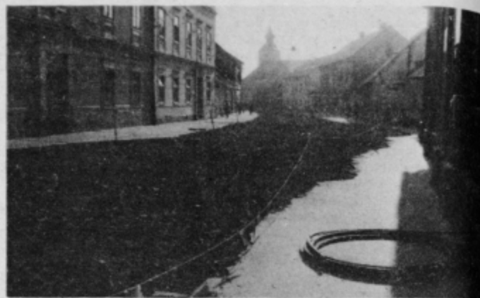
Del Partizanske ceste, bolj poznan kot Šolska ulica, bo po predvidevanjih do 10. novembra zaprt za ves promet
