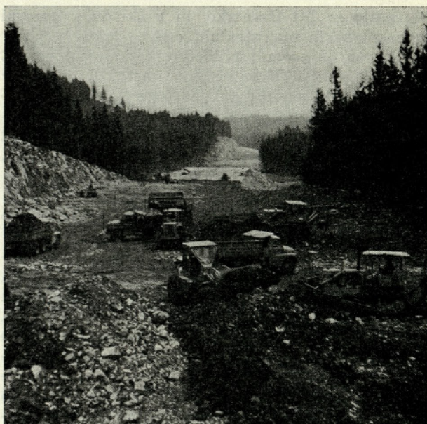
Gradnja avtoceste, odsek Unec—Postojna, izkop s težko mehanizacijo
