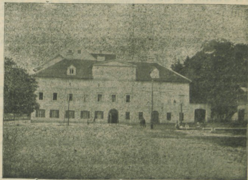
Im ersten Stockwerke dieses Hauses mit Garten werden
