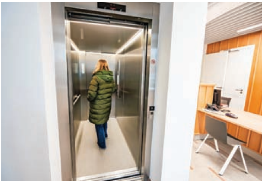
V skoraj sto let staro občinsko stavbo je po novem z večjim posegom, ki so ga izvedli ob prenovi, vgrajeno dvigalo. / Foto: Primož Pičulin
