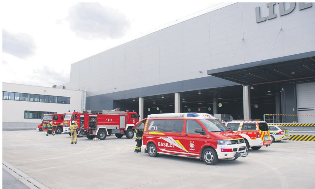
Minulo soboto so morali policisti in gasilci evakuirati logistični center podjetja Lidl v Arji vasi. Na kraj je prišlo 30 gasilcev iz okoliških prostovoljnih gasilskih društev. Pregled območja stavbe je pokazal, da požara ni bilo, prišlo pa je do napake v hidrantnem omrežju, so sporočili iz Gasilske zveze Žalec. Večja škoda tako ni nastala. Foto: Gasilska zveza Žalec
