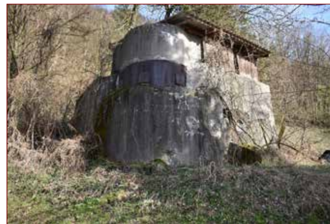
Slika: Vernikov bunker, Dravograd.
