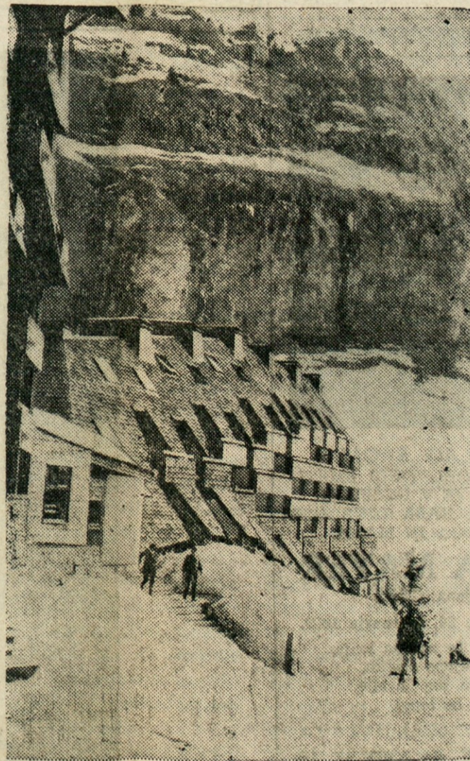
SPOJENO Z GORAMI — V francoskih Alpah so zgradili vrsto smučarskih domov, ki so skoraj naravnost pripeti za gorske stene in ne motijo prirodne ubranosti. Na sliki vidimo enega takih domov.
