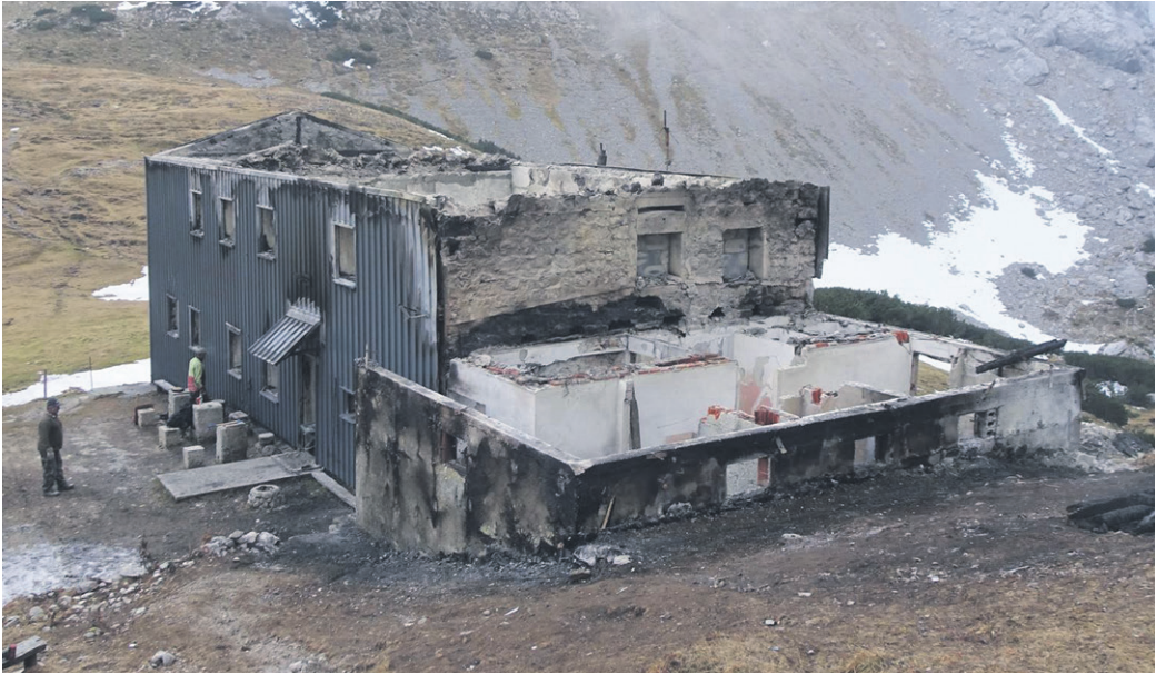
Kocbekov dom po požaru. Planinci lahko dobijo hrano, pijačo in prenočitev v začasnih zabojnikih pri nekdanjem domu. (Foto: arhiv PD Celje – Matica)
