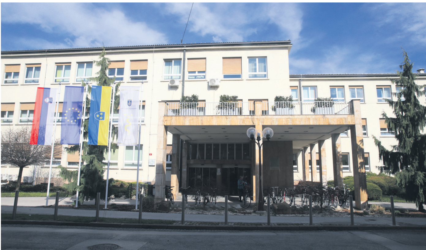
Stavbo celjskega zdravstvenega doma čaka temeljita obnova.
