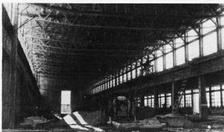
Gradnja notranjih prostorov.
