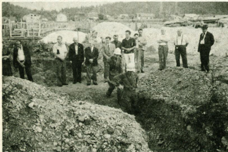
KS Vir – takole so pričeli z gradbenimi deli gradnje Gasilskega doma
