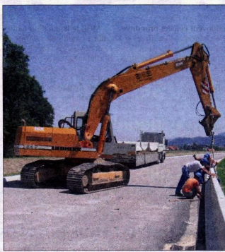
Na priključni cesti, po kateri je za na celotni trasi plozob grob asfalt, hitijo z nameščanjem varovalnih betonskih ograj.
